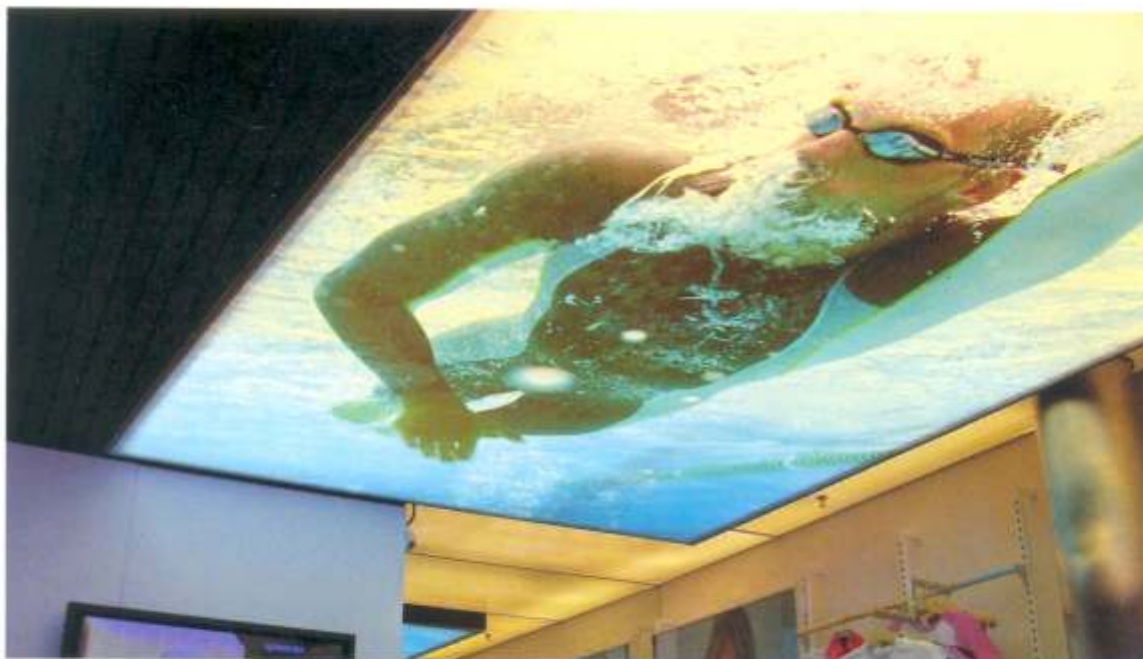
Tecido flexível com fluorescentes T8/32W gera iluminação difusa, marcando a entrada da loja.
